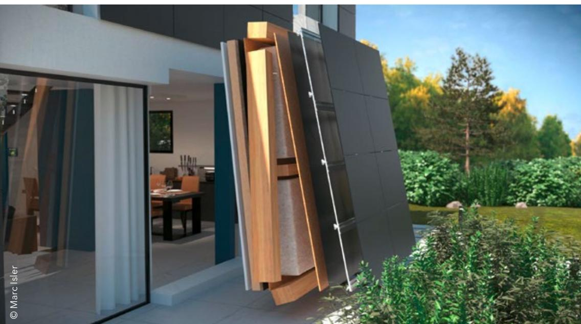
Das Modulhaus wird in Holzrahmenbauweise vorkonstruiert.
